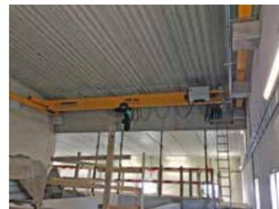
de l'emplacement de la voie de roulement et de l'assemblage du pont roulant. Grâce au délai de livraison intéressant offert par Mennens BE, il a été possible de placer le pont roulant avant la fermeture du toit. L'assemblage final de la grue, du palan et du kit électrique a eu lieu quelques semaines plus tard.
