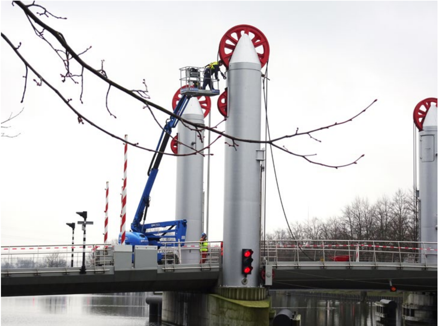
Montage van de kabels in volle gang.
